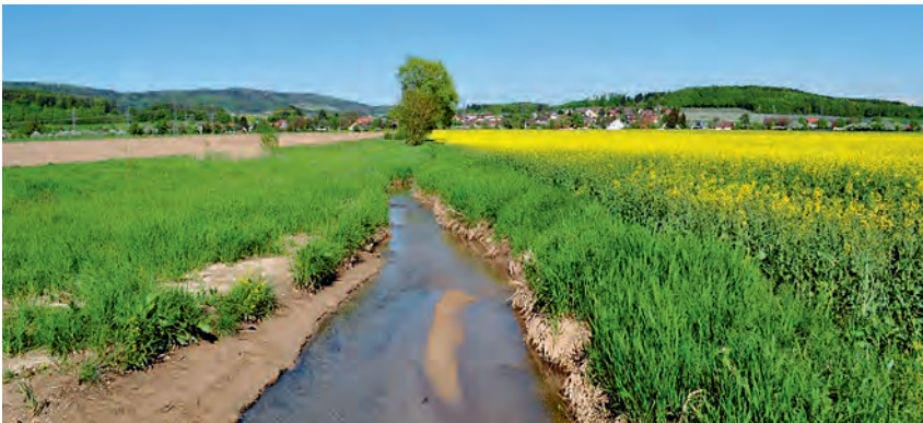
Renaturierung eines Bachlaufs (Einrichtung von Gewässerrandstreifen, Entfernen von Betonhalbschalen, naturnahe Gestaltung des Bachlaufs)
